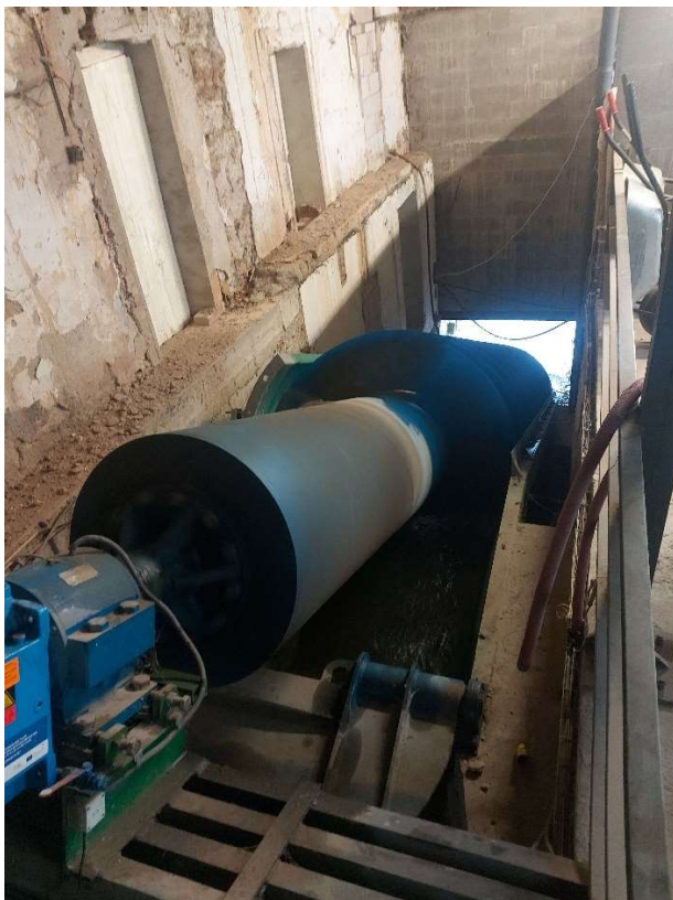
Obrázek 10. Samonosný ocelový žlab.
